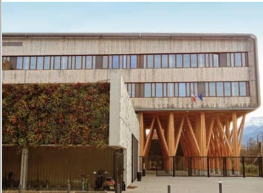
La mise en œuvre consiste en la fixation de cages grillagées équipées de géotextile et de substrat dans lesquelles est organisée une composition de plantations bien précise.
